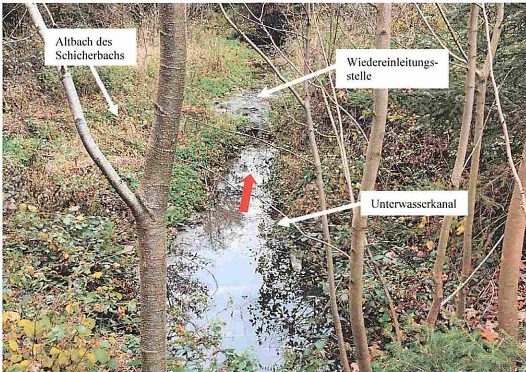
Bild 5.5: Unterwasserkanal und Wiedereinleitungsstelle
